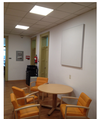
Abb. 13: Wandabsorber zur besseren Sprachverständlichkeit
