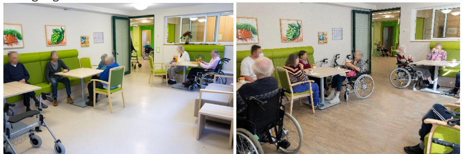
Abbildung: Aufenthaltsraum mit Blick Richtung Flur, linkes Bild Bestandssituation 2018, rechtes Bild 2022 nach Austausch des Bodenbelags
